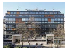
16 Immeuble Clarté Le Corbusier
